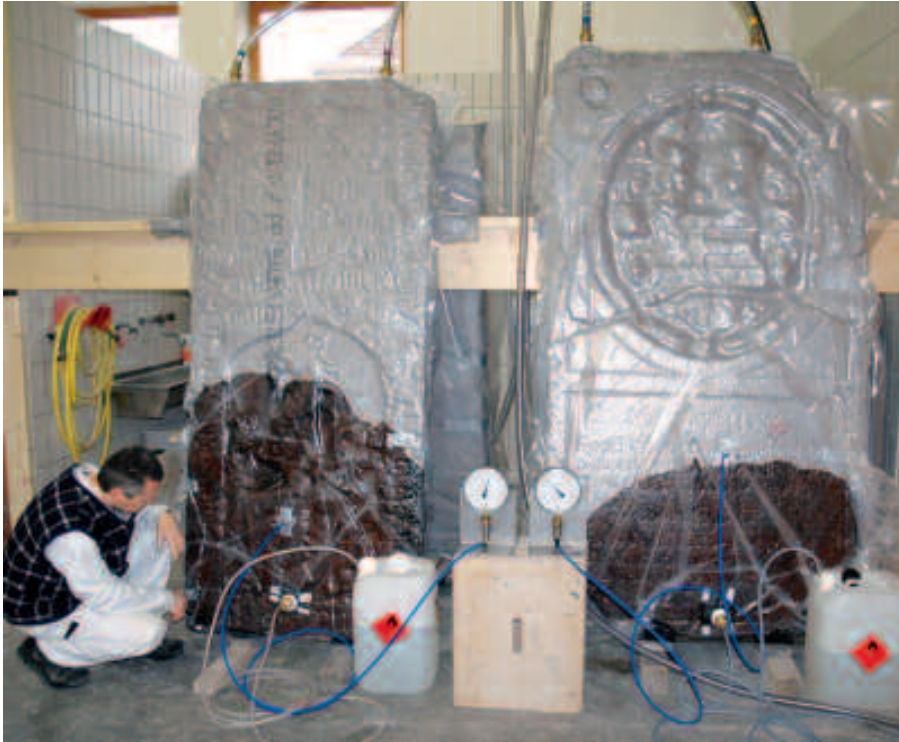
Epitaphe der Pfarrkirche Tulln: Der rote Knollenkalk wird mit 10% Paraloidlösung in Xylol gefestigt.
